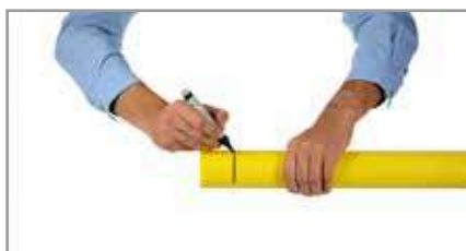
7. Marcar a profundidade de inserção do tubo.
