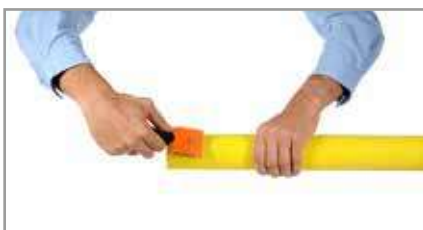
5. Raspar a zona de soldadura do tubo.
