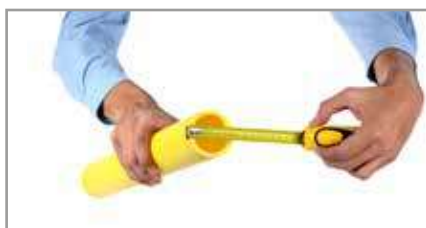
1. Medir o diâmetro do tubo.
